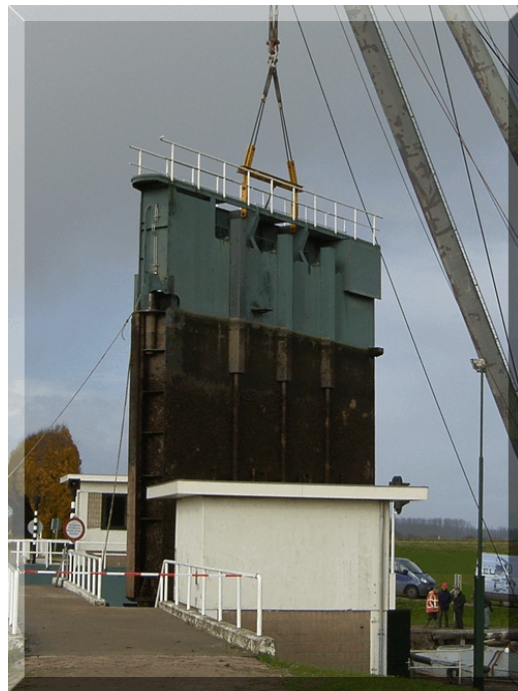
Afbeelding 3 toont een sluisdeur waarbij de draaipunten van 55 µm Lunac 2+ zijn voorzien. Het bovenste draaipunt opereert in de lucht-water overgang. Ook tegen deze corrosiebelasting is Lunac 2+ bijzonder goed bestand.
